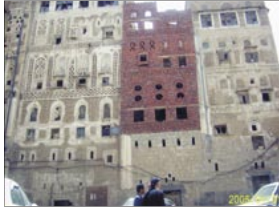
● بعد الترميم: الخولاني بطوب أحمر
